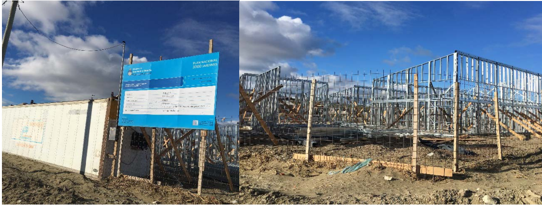
Imagen N°29 y 30: Escuela de Nivel Inicial en construcción en el barrio DRGF.
