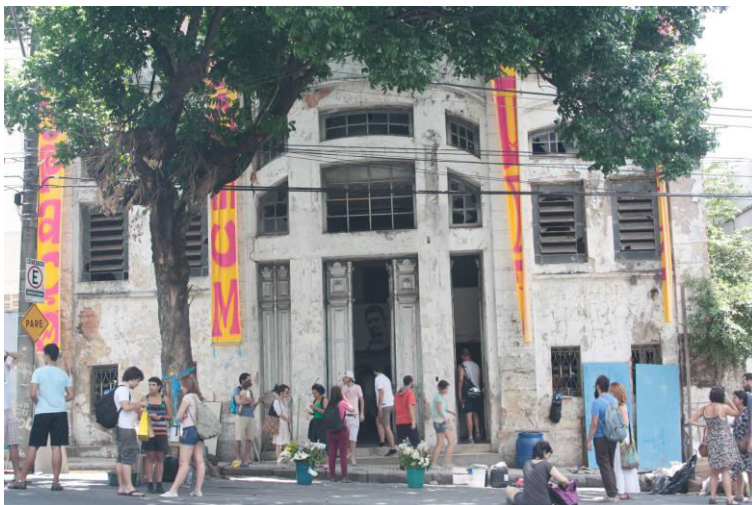
Figura 6 – Fachada do Espaço Comum Luiz Estrela
