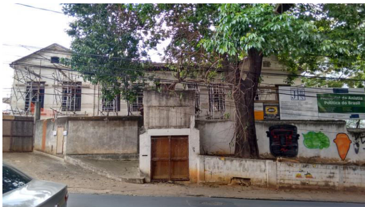
Figura 2 – Fachada em obras do “coleginho” – Memorial da Anistia
