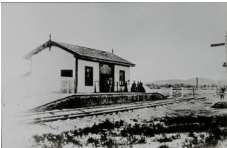
Figura 3 - Estação Ferroviária de São Bernardo, atual Estação Prefeito Celso Daniel - Santo André, inaugurada em 16 de fevereiro de 1867. Hoje neste local está a passarela de pedestres. Coleção RFFSA. Acervo MSAOAG.
