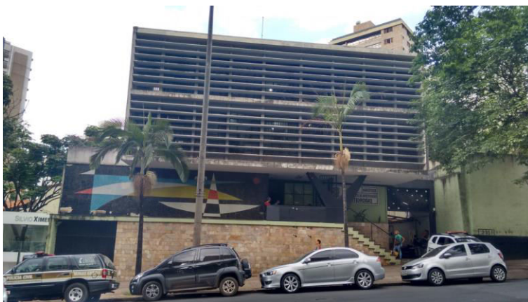
Figura 3 – Vista da fachada do Edifício do Antigo DOPS.
